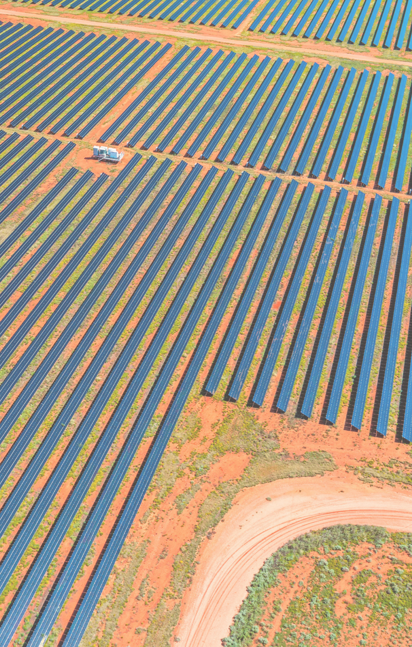
▲ Nyngan Solar Plant, Nyngan, NSW
