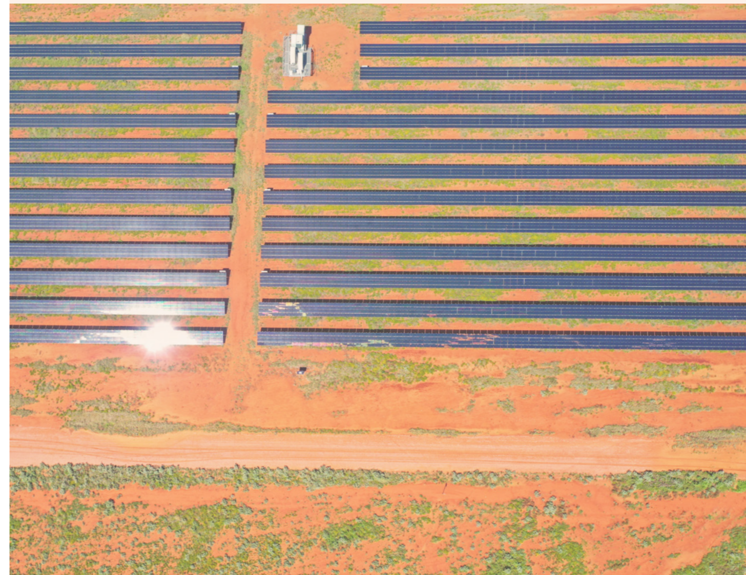
▼ Nyngan Solar Plant, Nyngan, NSW
